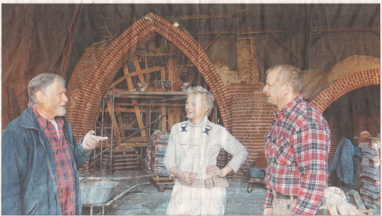
Die Windberger Backsteinwelten wachsen weiter: Bernd Schreiber (von links), Jacqueline Rossow und Kay Neuling besprechen den Bauablauf für das neue, gotische Kreuzrippengewölbe im Hintergrund. Foto: Birgit Schultze
